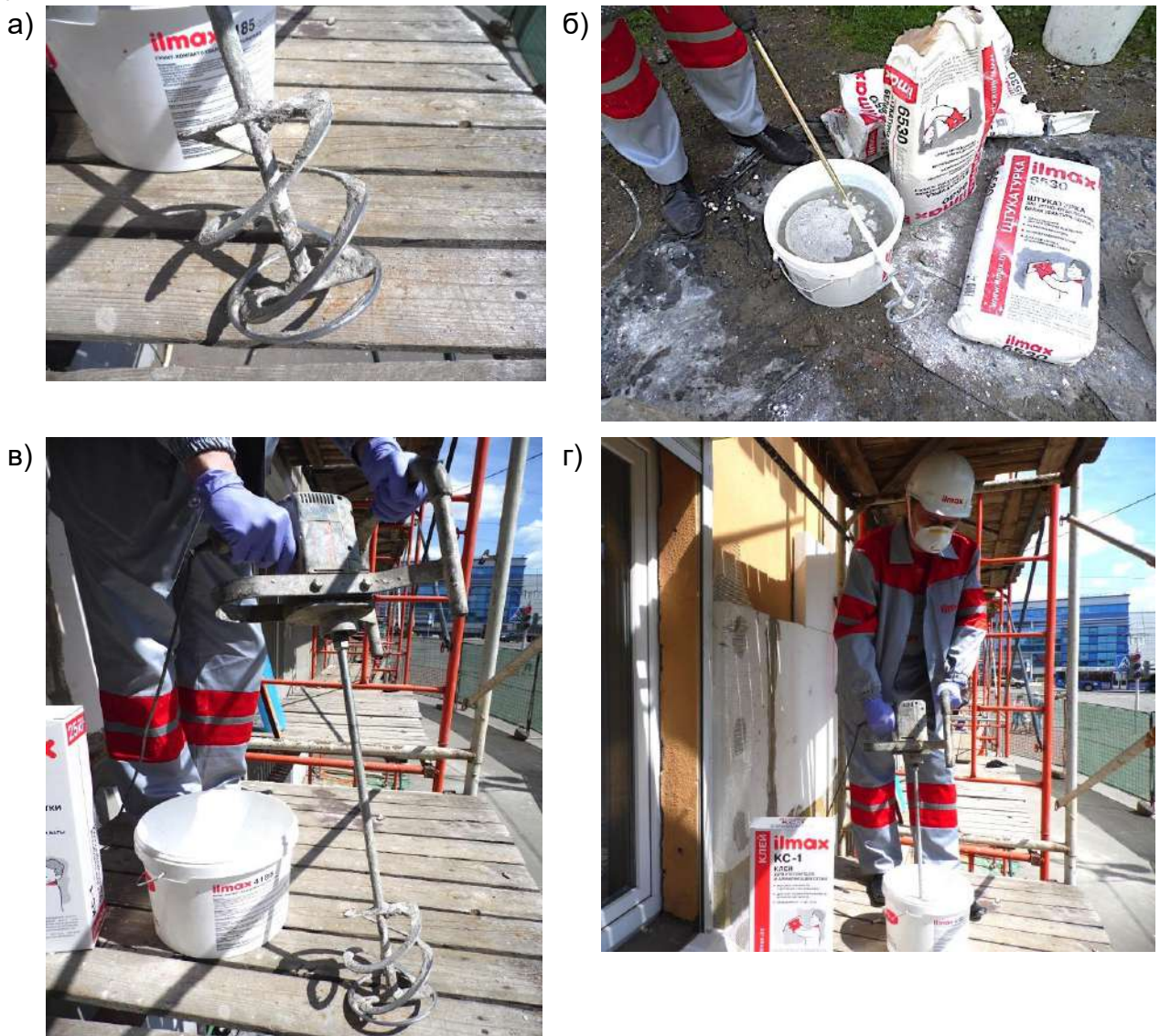
а – насадка для приготовления клеевой смеси; б – насадка для приготовления защитно-отделочной штукатурки; в – миксер и емкость для приготовления состава; г – приготовление состава
