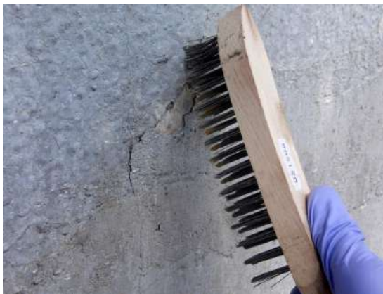
Рисунок 5 – Очистка основания стальной щеткой
