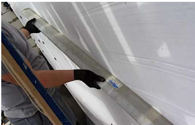
Рисунок 15 – Проверка ровности приклеенных плит утеплителя
