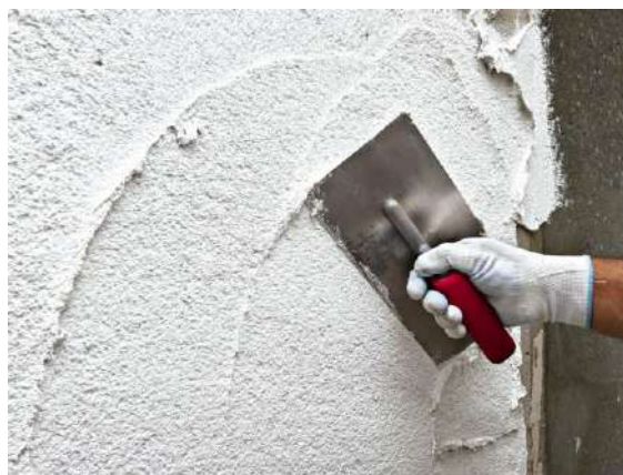
Рисунок 30 – Нанесение защитно-отделочной штукатурки металлической теркой
