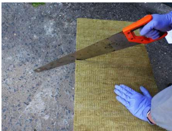
Рисунок 11 – Подрезка плит утеплителя ножовкой
