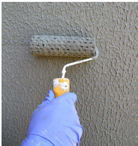
Рисунок 32 – Формирование фактуры «шуба» структурным валиком
