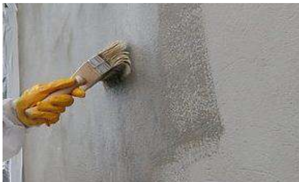
Рисунок 34 – Грунтование поверхности кистью
