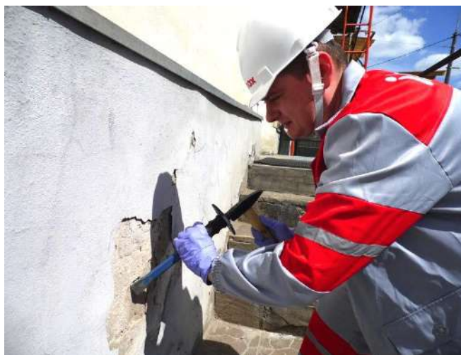
Рисунок 6 – Сбивка непрочных участков оштукатуренной поверхности основания зубилом и молотком
